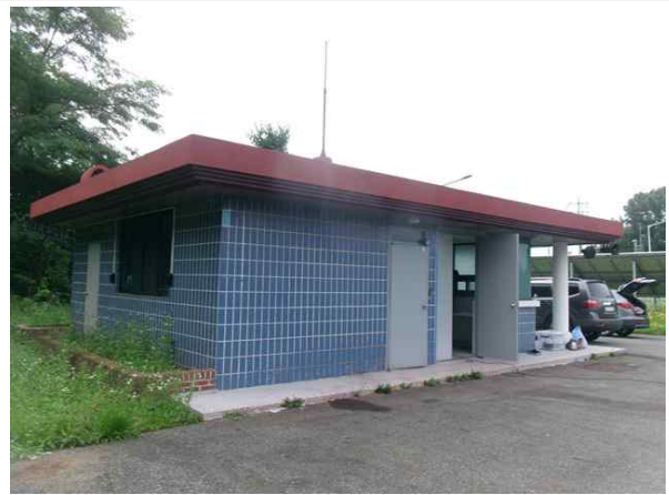
손상내용 관리동 외부 상태양호 손상원인 -
