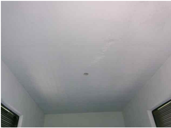
손상내용 계단실 내부 상부슬래브 상태양호 손상원인 -
