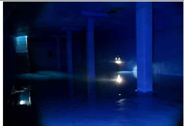
배수지 2지 내부 전경
