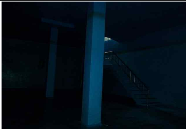
배수지 1지 내부 전경
