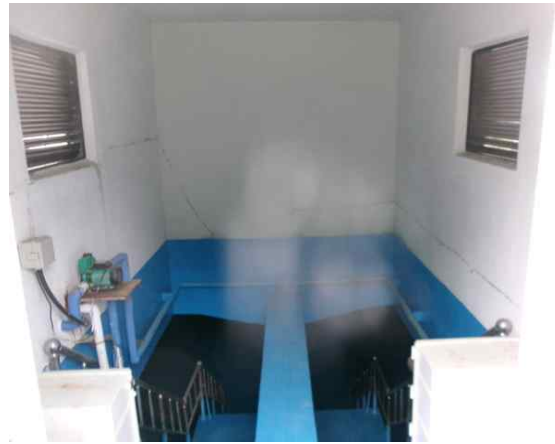
손상내용 계단실 내부 벽체 상태양호 손상원인 -
