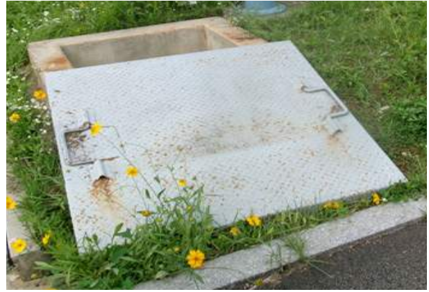
환기구 등의 덮개(장비 반입구) 현황
