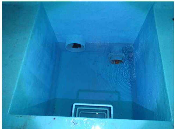
손상내용 2지 유출 배관 현황 손상원인 -
