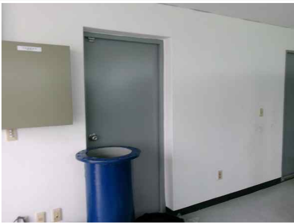
손상내용 관리동 내부 상태양호 손상원인 -
